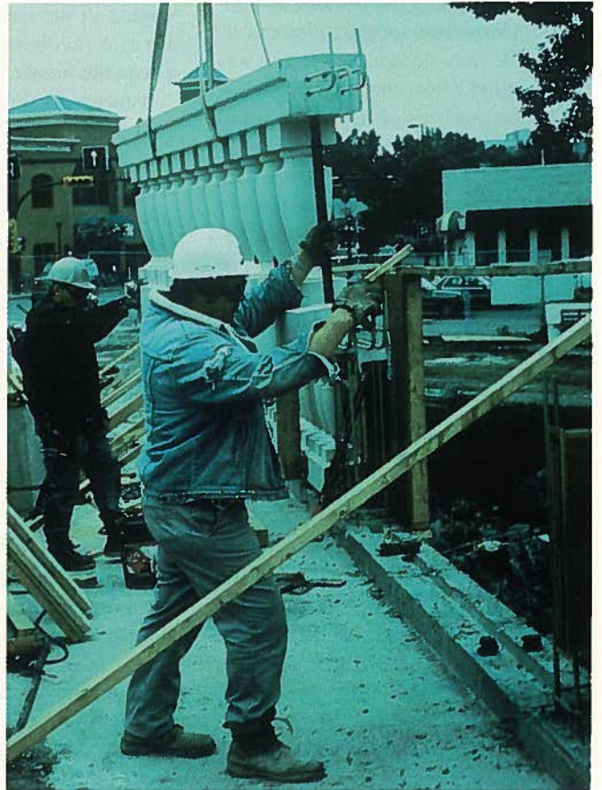
Fig. 10. Installing precast balustrade.
