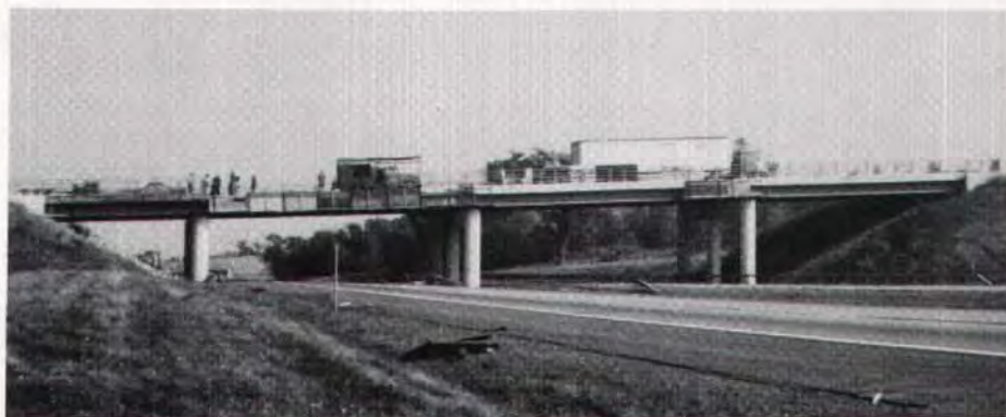
Fig. 12. Amsterdam Interchange Bridge (NYSTA).
