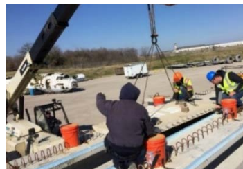
(d) placing of precast deck panels
