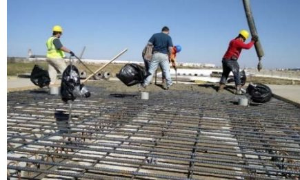
(h) concrete pouring
