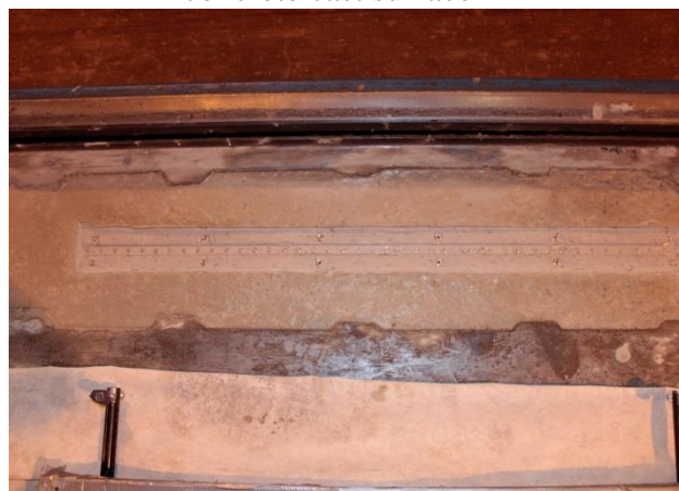
(d) Concrete surface with brass inserts
