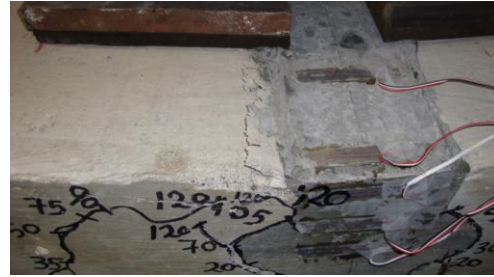
(d) Concrete crushing in slab S6
