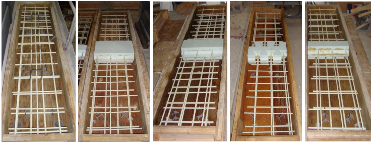
(a) Slab S2 (b) Slab S3 (c) Slab S4 (d) Slab S5 (e) Slab S6
