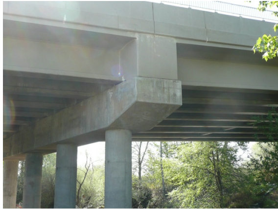
Fig. 14 Pier Diaphragm
