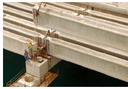
(d) Precast Girder Placement
