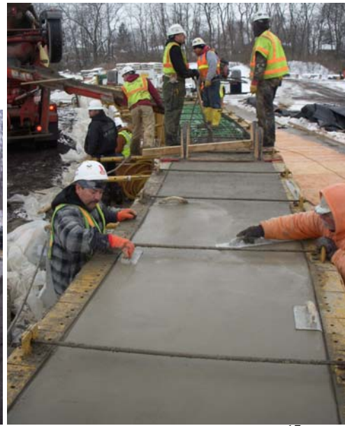
Fig. 16 Segment Pour & Finish 17
