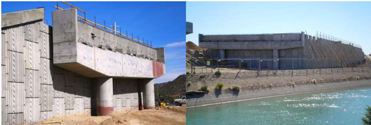
Fig. 14A – West Abt 1E & precast MSE wall. Fig. 14B – East Abt 2E & precast MSE wall.
