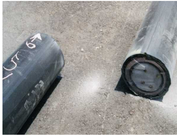
Fig. 16 Split PE Pipe Repair
